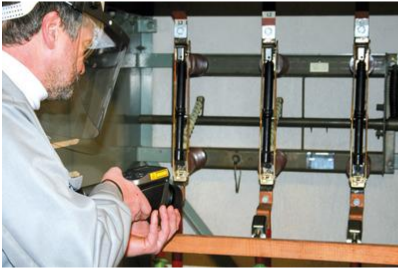
Bild: "Vorführung MÜE (Stadtwerke Dreieich): Thermographische Analyse"
