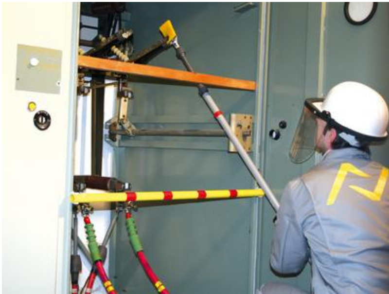
Bild: "Vorführung MÜE (Stadtwerke Dreieich): Feuchtreinigung"
