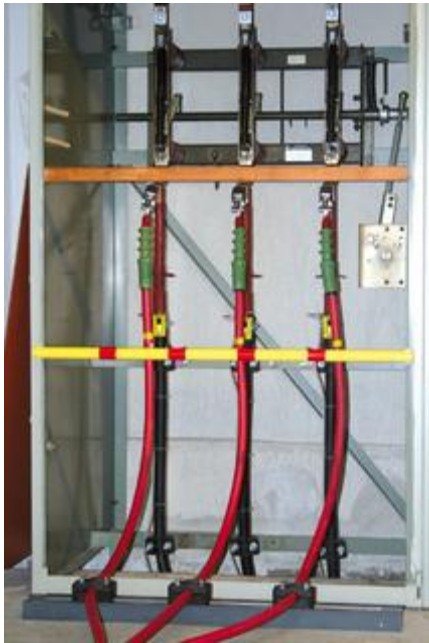
Bild: "Vorführung MÜE (Stadtwerke Dreieich): Eingebrachte Trossenkabel"
