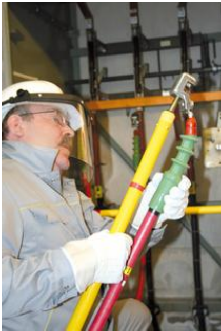
Bild: "Vorführung MÜE (Stadtwerke Dreieich): Einbringen der Trossenkabel"
