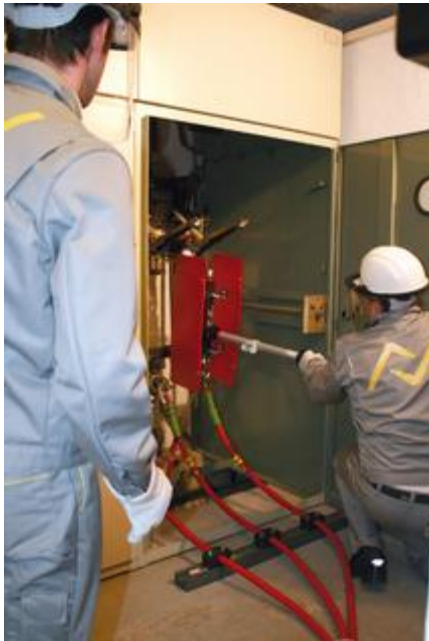
Bild: "Vorführung MÜE (Stadtwerke Dreieich): Entfernen Trafosicherung"
